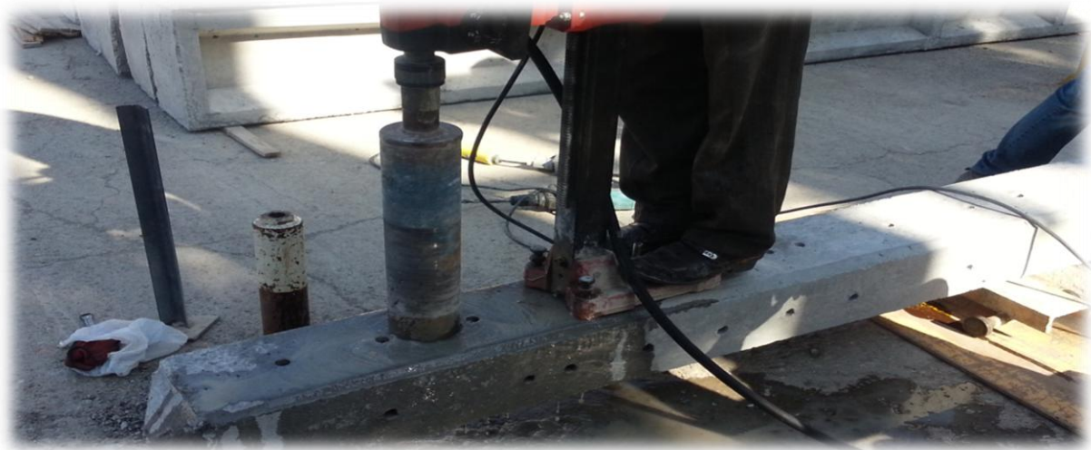
شکل (۳۰) نمونه مغزه گیری بتن از راس پایه
